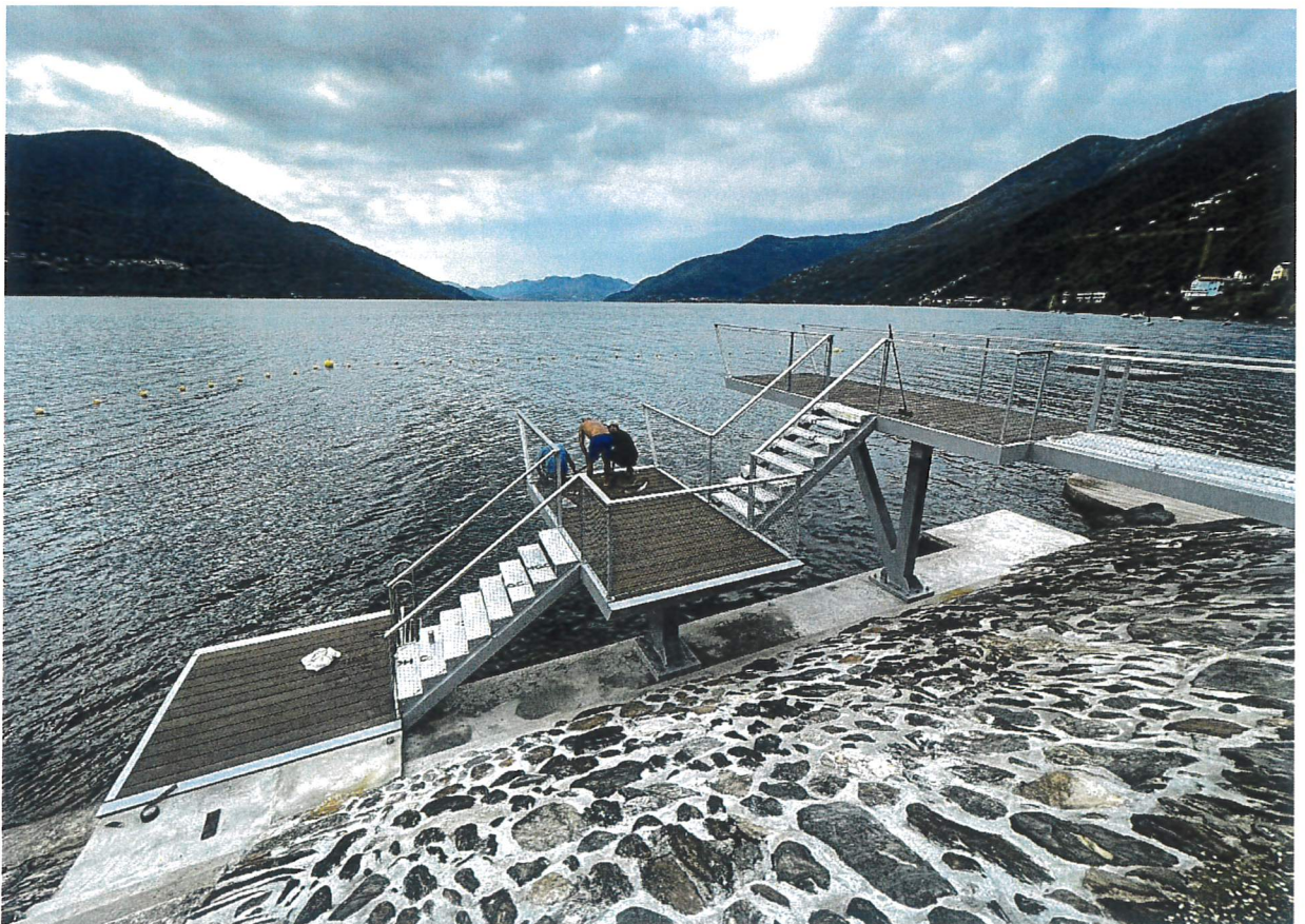
Foto 4 (ricostruzione della scogliera e fine lavori di posa)
