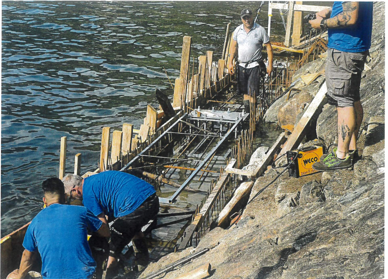
Foto 3 (saldatura rinforzi metallici nella gabbia d'armatura)
