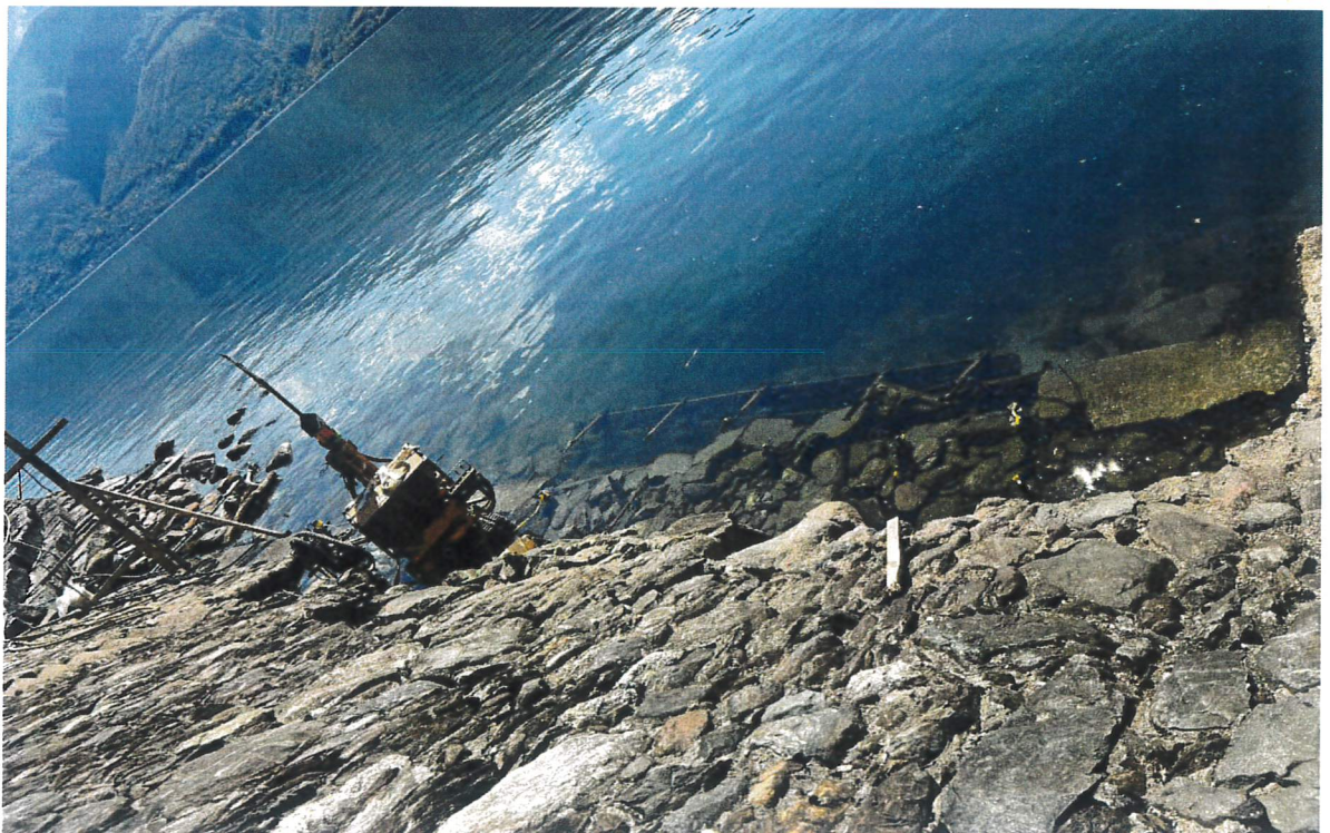
Foto 2 (scogliera ceduta e nuovi pali di fondazione)
