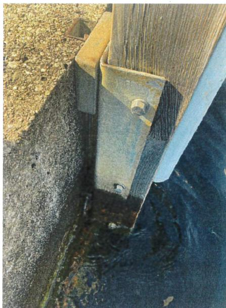
Figura 5 Fissaggio parabordi
