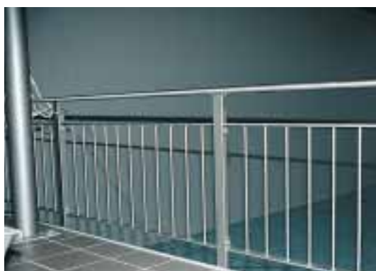
Ringhiera costituita da aste verticali: altezza min. 1.1 m, difficile da scalare, trasparenza garantita
